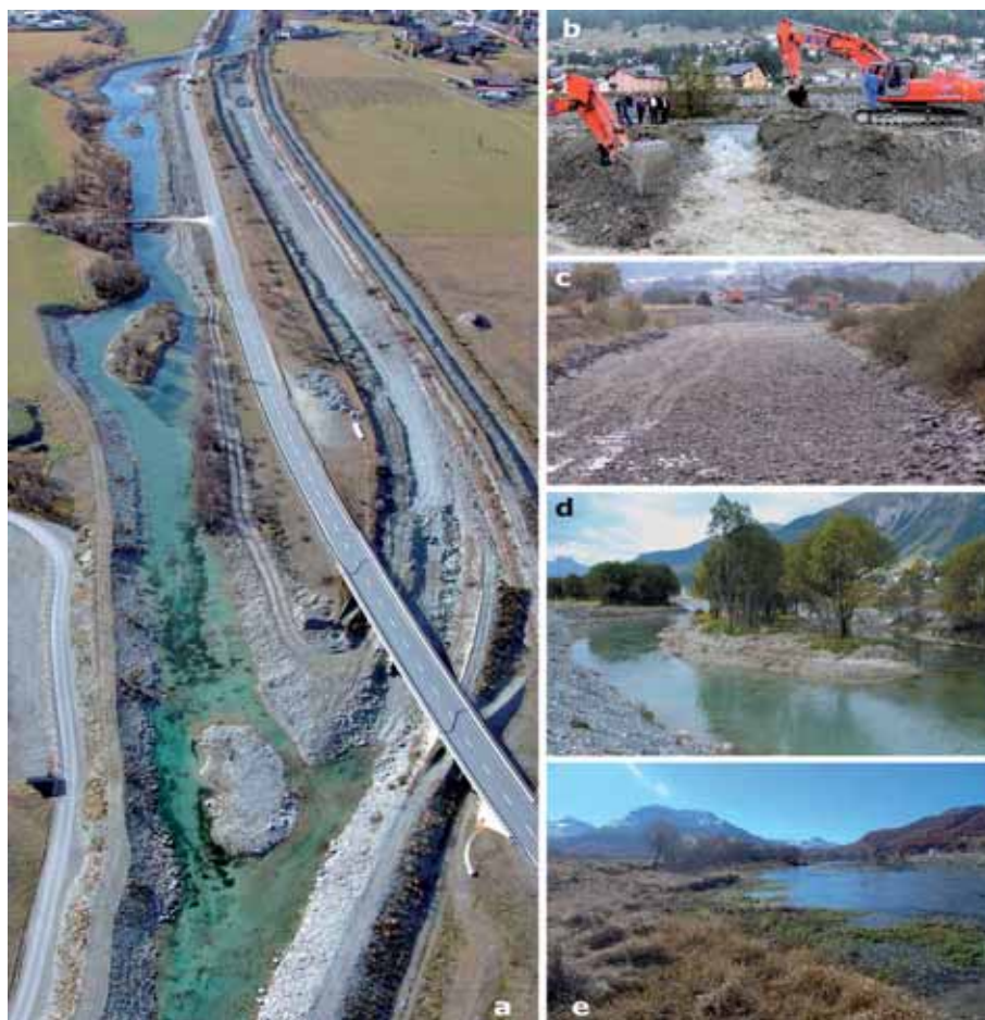
Bild 16. Die En-Ausleitung: Die neue Gestalt des En unterhalb von Samedan: a) Verlauf der En-Ausleitung von Fussgängerbrücke bis Kantonsstrassenbrücke (nach der Flutung, Nov. 2005); b) Moment der En-Ausleitung am 22. September 2005; c) leerer ehemaliger En-Kanal nach Ausleitung; d) eines der als Insel erhaltenen Uferstücke des ehemaligen En-Altlaufs; e) rechtes, erhaltenes Ufer des ehemaligen En-Altlaufs.
