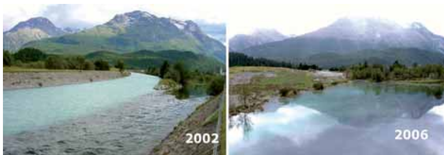
Bild 12. Auch die landschaftliche Aufwertung kommt in diesem Projektabschnitt besonders deutlich zur Geltung. Aus einem Zusammenfluss zweier kanalisierter Flüsse wurde eine Gewässerlandschaft, die den ursprünglichen Charakter und die ökologische Funktionsfähigkeit einer Gebirgsaue aufweist.
