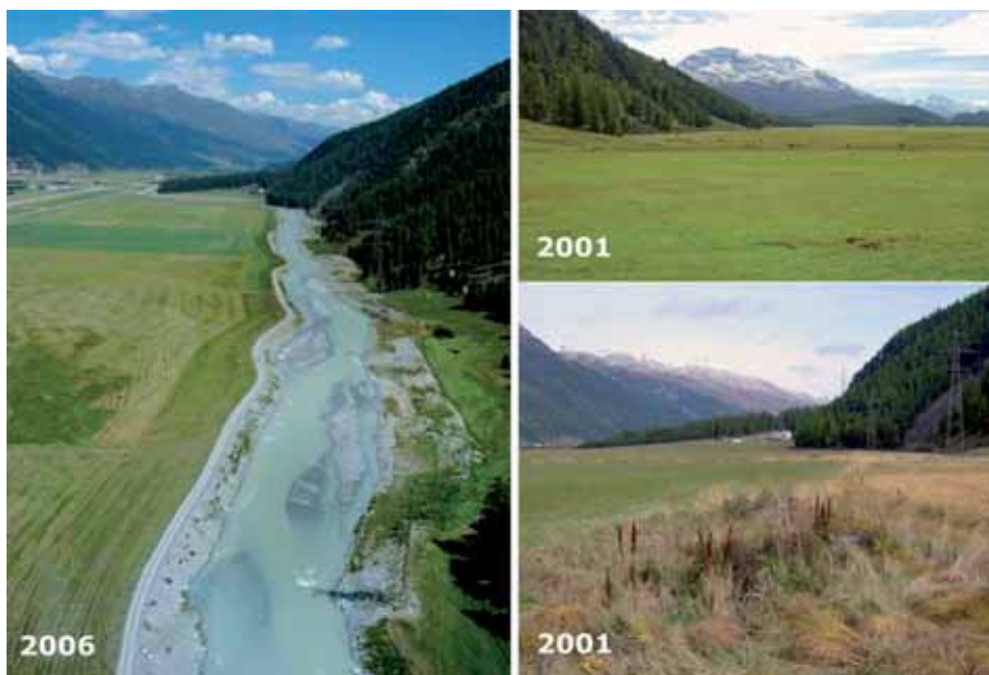
Bild 14. Der Neue Flaz: Wo 2001 noch eine Rinderweide von kleinen Drainagekanälen durchzogen wurde (Bilder rechts), fliesst heute ein von Menschenhand geschaffener, rund 4 km langer Gebirgsfluss, der Neue Flaz (linkes Bild).
