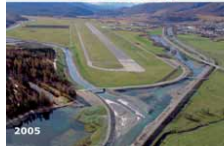
Bild 8. Rechte Bildleiste: Neue Flazmündung (Blick von Gravatscha En-aufwärts in südlicher Richtung): Die neue Flazmündung unterhalb von Samedan stellt eine technische Lösung mit naturnahen Elementen dar. Damit das Wasser von Gravatscha nicht durch Flazwasser, welches häufig Gletschermilch enthält, getrübt wird, wird der See durch einen Düker unter dem Flaz hindurch mit Enwasser gespeist. Der auf der linken Flazseite in die Mündung vorgezogene Sporn wurde zwischenzeitlich stark abgetragen.
