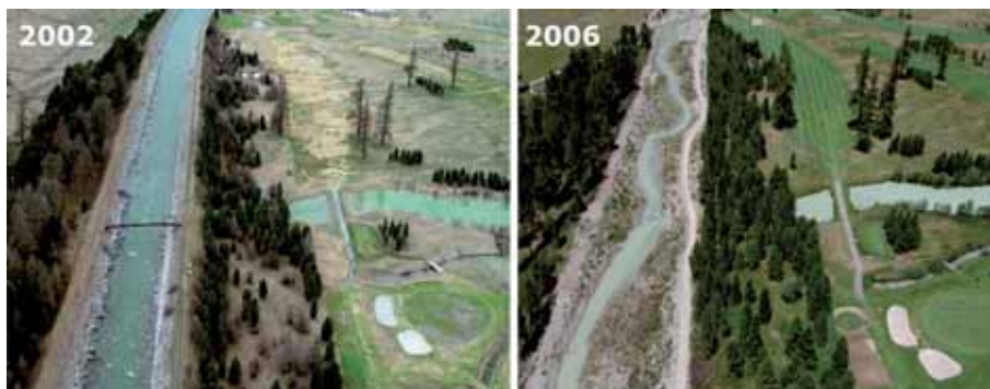
Bild 13. Flaz vegl (Blick bachabwärts in westlicher Richtung): Im ehemaligen Flazkanal fliesst heute der renaturierte Lauf des Flaz vegl mit noch maximal 1,5 Kubikmeter Wasser pro Sekunde. Die alten Flazdämme konnten zurückgebaut werden, die Vegetation schliesst langsam die «Wunden» in der Landschaft. Der rund 2,5 km lange Lauf des Gebirgsbachs hat sich bereits zu einem beliebten Naherholungsgebiet entwickelt.
