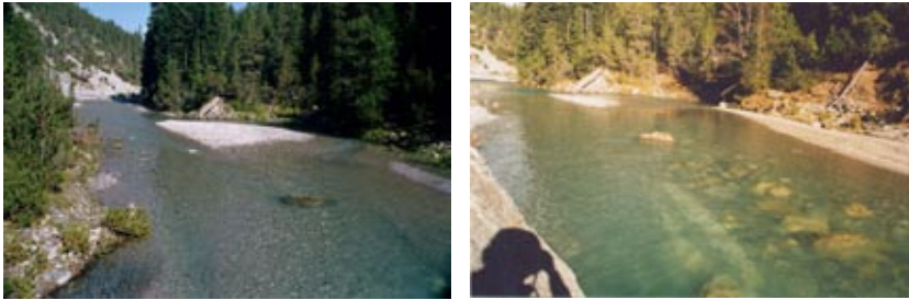
Abb. 5: Gewässerabschnitt oberhalb Pt. Periv; die ersten künstlichen Hochwasser 2000 führen zu Aufschotterung und Bildung neuer Kiesbänke; die folgenden Hochwasser führen zur Erosion und Rinneneintiefung
