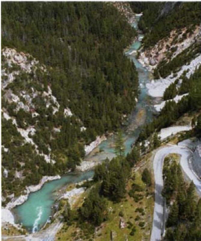
Bild 1a. Blick von der Staumauer Punt dal Gall auf den Spöl bei Restwasserabfluss (1999).
