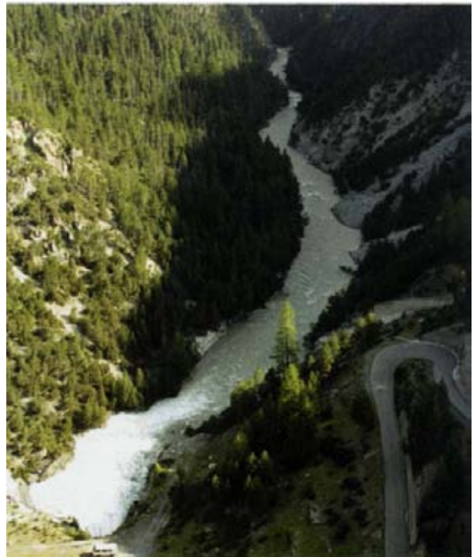
Bild 1b. Blick von der Staumauer Punt dal Gall auf den Spöl bei Hochwasserabfluss (ca. 30m 3 /s; 5. Juli 2001).
