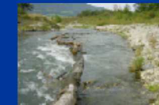
Tothölzer können so eingebracht werden, dass eine grossflächige Beeinflussung der Strömung erreicht wird (Strömungsvariabilität). (Revitalisierter Mündungsbeereich des Liechtensteiner Binnenkanals)
