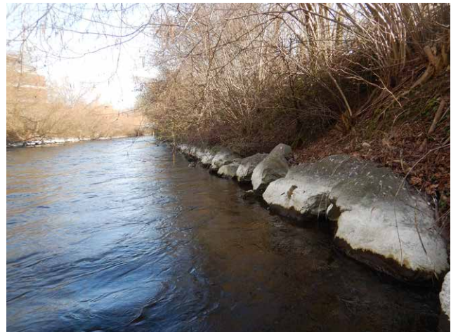
Mit grossen Blöcken befestigtes linkes Ufer.
