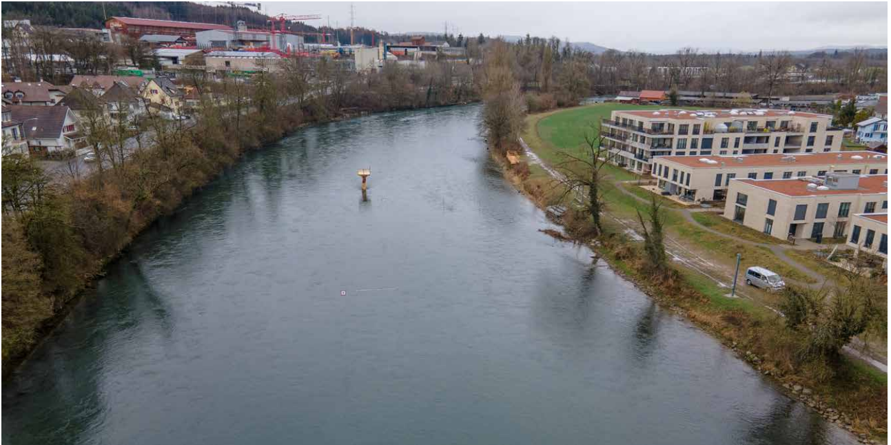
Mittelland-Reuss unterhalb der Wehranlage Bremgarten flussabwärts betrachtet.
