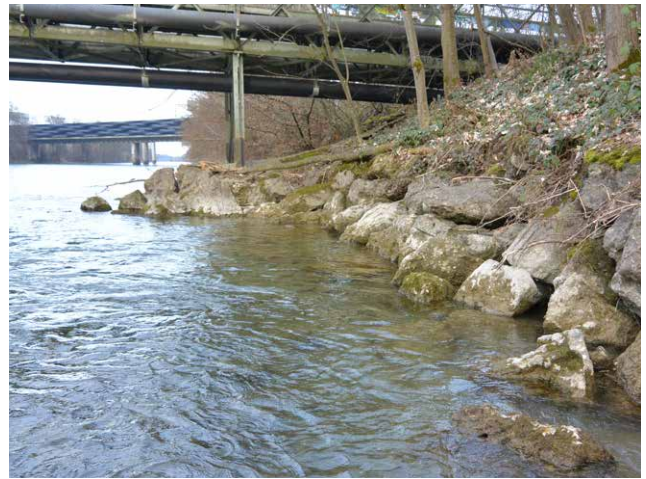
Sich teilweise auflösender, sehr grober Uferverbau am rechten Ufer. Flachwasserbereich ebenfalls mit grobem Substrat.
