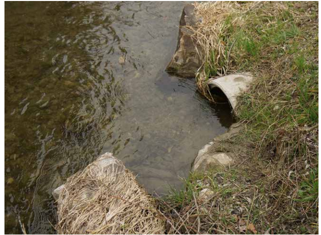
Zuleitung am rechten Ufer - vermutlich Regenwassereinleitung.
