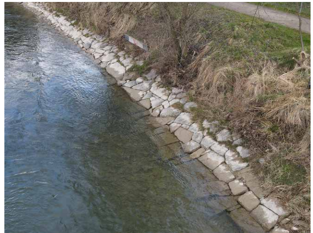
Leicht durchlässiger, im Längsverlauf durchgängiger Uferverbau am rechten Ufer.
