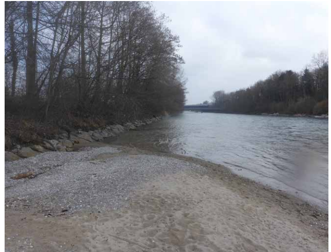
Ausläufer der Kiesbank von der Einmündung der Kleinen Emme geht am linken Ufer in festen Uferverbau über.
